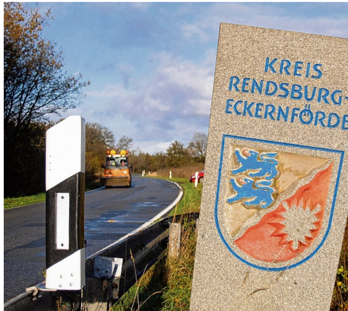
Im Ausbauprogramm für 2014: Die Landesstraße 123 wird im kommenden Jahr vom Ortsausgang Meezen bis zur Kreisgrenze nach Steinburg auf 350 Metern Länge saniert. KÜHL
