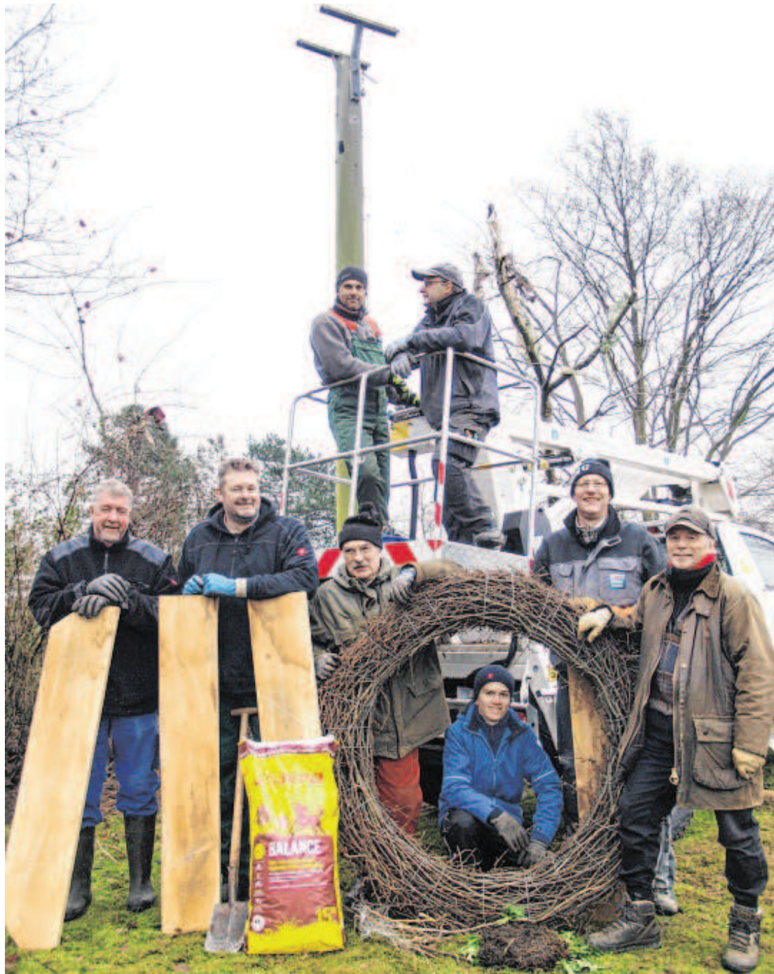
Gemeindliche Sanierungsaktion: Bürgermeister Thorsten Reimers (links) mit den engagierten Storchenest-Renovierern. FOTO: KÜHL
