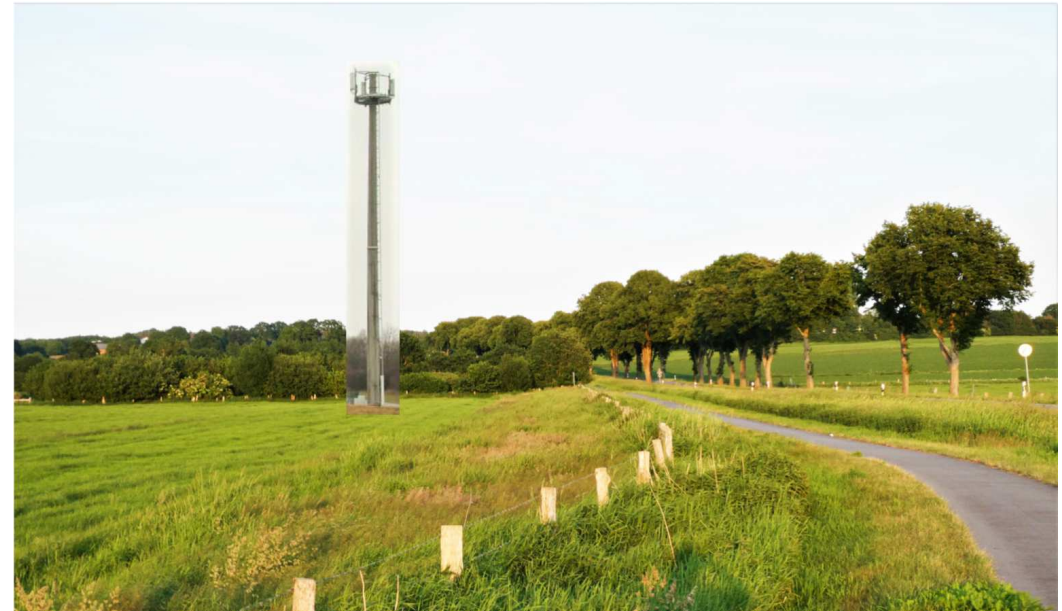
künftige Sicht auf die Lindenallee mit Mobilfunk-Betonmast
