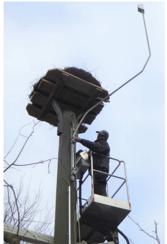
Die Kamera-Halterung wird von Matthias am Mast befestigt, die Kamera sendet erstmals Bilder, aber der per Smartphone kontrollierte Bildausschnitt ist noch nicht optimal eingestellt. Deshalb erneute Demontage von Halterung samt Kamera, um deren Aufnahmeposition zu verbessern.
