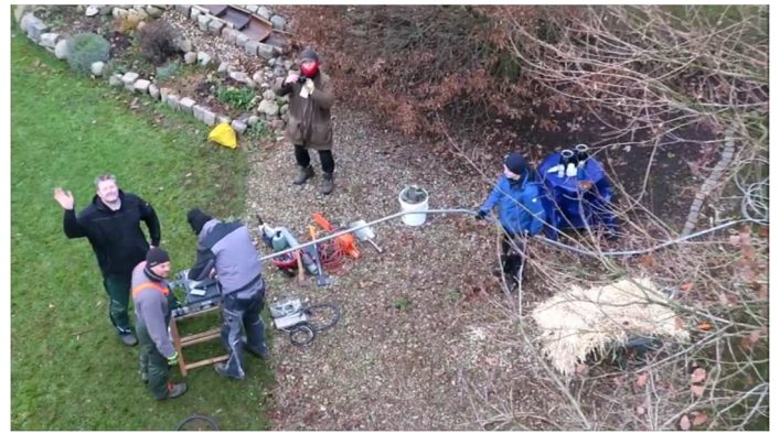
Blick auf die Montage von der Arbeitsbühne aus.
