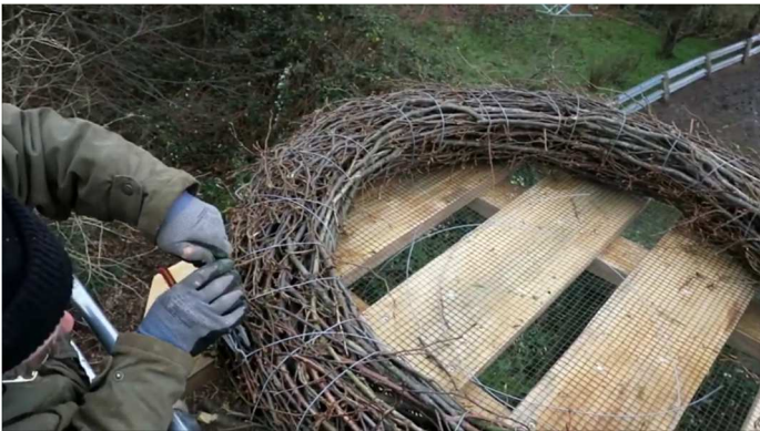
... der Reisigring auf der Bodenplatte befestigt.
