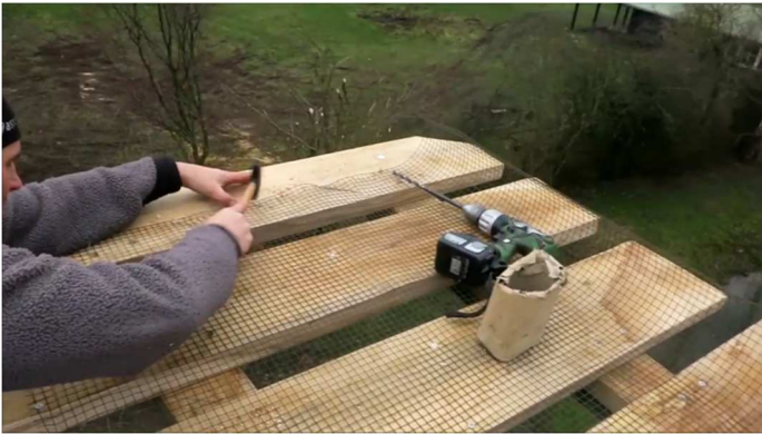
Dann wird engmaschiger Draht aufgenagelt und
