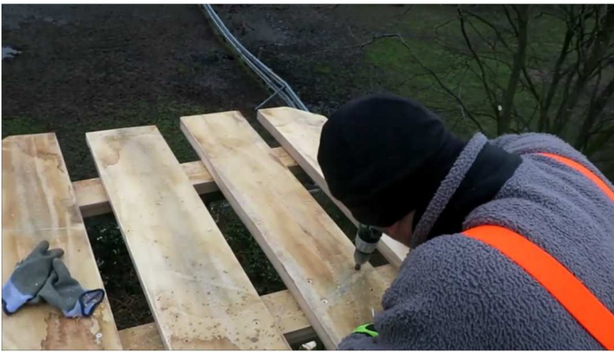
Aus den vorgefertigten Eichenbohlen wird die Bodenplatte montiert.
